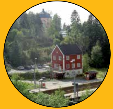
Høybråten Stasjon med Vel-Huset
