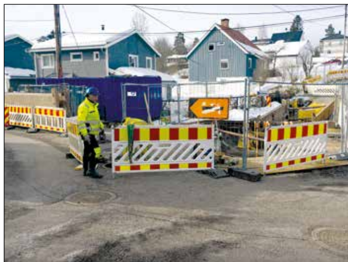
Vann- og avløpsarbeid i krysset Fredheimveien/Bikuben.
